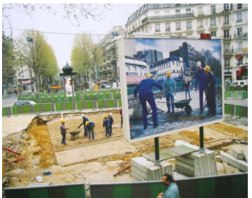
Pierre HUYGHE, Chantier Barbès-Rochechouart , 1994.
